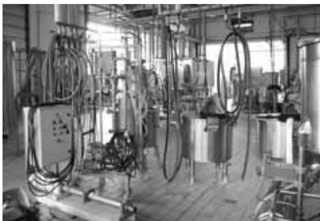
Poloprovozní technologická hala v areálu INRA, Agrocampus, Rennes, Francie.
