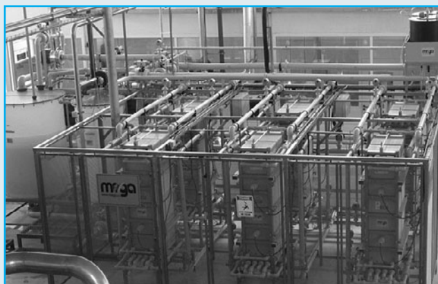
Obr. 9 Elektrodialyzační jednotka EWDU 6x EDR-II/250
